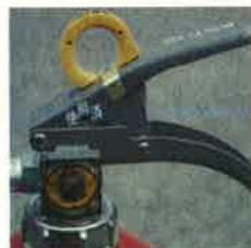
× 表示装置の脱落
