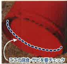
× 底部の腐食
